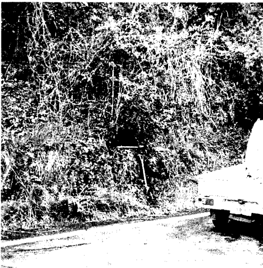
図9 No.1 地点工事法面2の現状 (試料No.1(径約50cm)出土地点)
